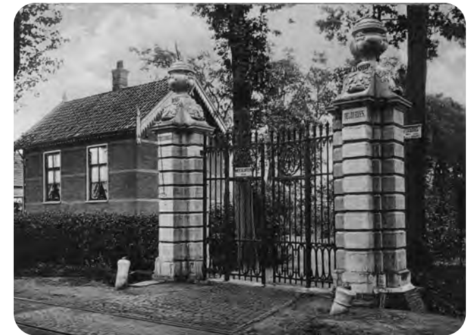
Het nog bestaande hekwerk bij de entree, met voormalige dienstwoning (omstreeks 1920)
