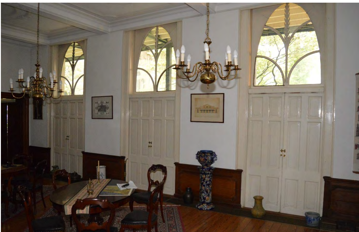
De vensterwand in de ontvangstkamer op de begane grond van het landhuis, bestaande uit hoge deurenkozijnen met schuifluiken en sierlijke vroeg-19 de -eeuwse bovenlichten.
