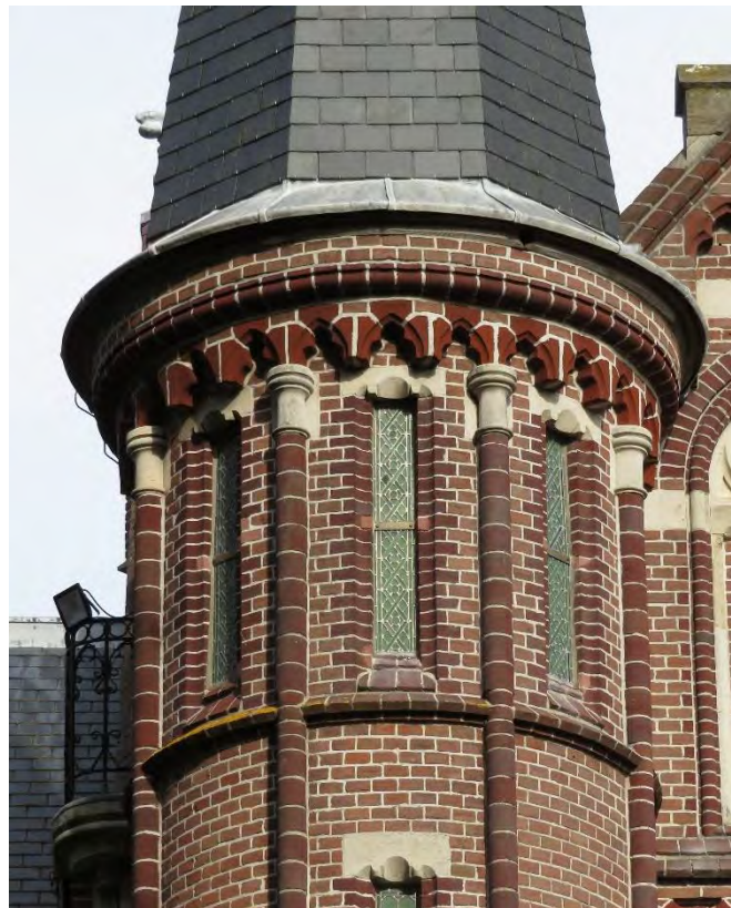
Links: een travee van de zuidelijke gang tegen de kapel (1895). Ten behoeve van deze gang zijn de steunberen verbreed en voorzien van doorgangen. Elke travee is ingevuld met een eenlaags aanbouw. Rechts: de bovenste verdieping van de zuidelijke traptoren, geleed door ronde pilasters en een boogfries van profielstenen.
