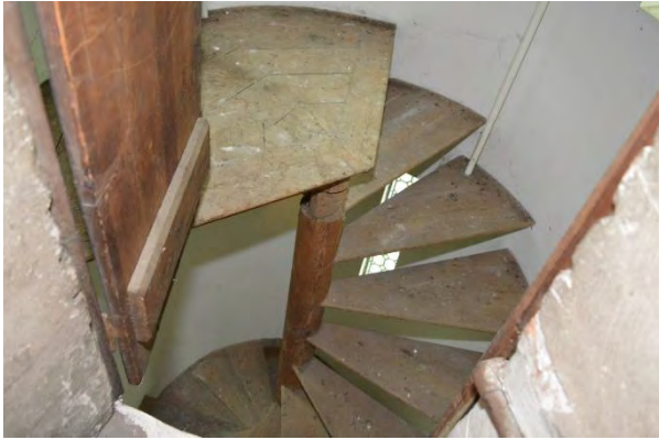
Beëindiging van de (open) spiltrap in de noordelijke traptoren van de kapel.
