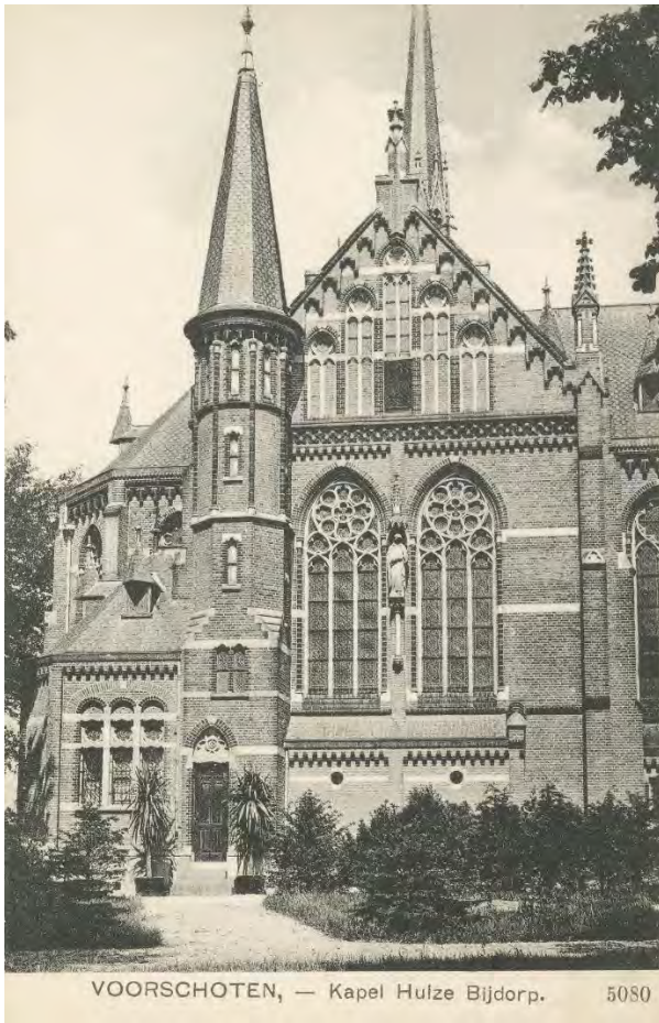
De zuidgevel van de kapel van Huize Bijdorp, Ansichtkaart uit het begin van de 20 ste eeuw (Erfgoed Leiden, nr. LEI001008801). De kopgevels van de beide dwarsbeuken hebben een rijke decoratie in neogotische stijl. In de onderzone bevinden zich de twee uitgebouwde biechtstoelen.
