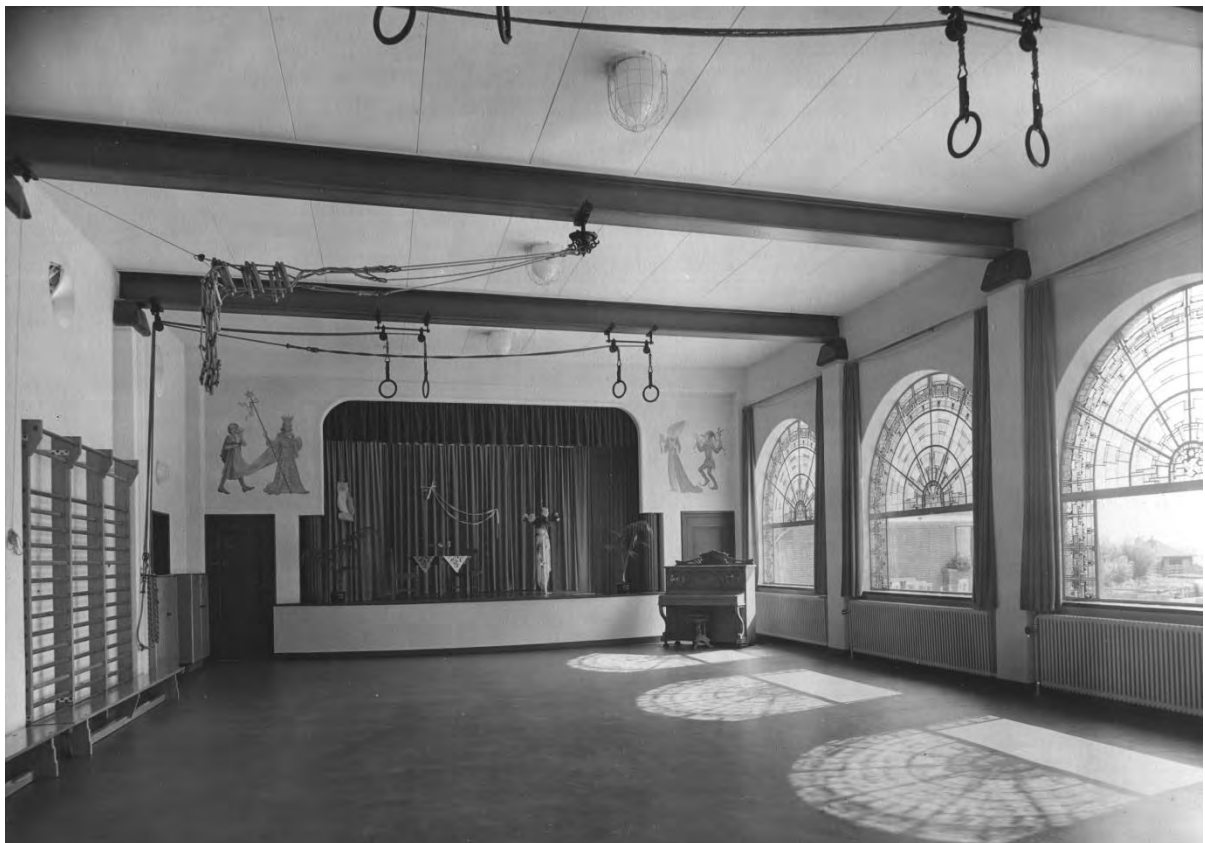
Het gymnastieklokaal in het nieuwe pensionaat, circa 1938 (Erfgoedcentrum Nederlands Kloosterleven, ENK_AR-Z040-3011-03). De balken in het plafond bestaan hier nog uit (onbeklede) stalen balken. De consoles op de pilasters zijn behouden. De bovenlichten van de vensters zijn hier nog ingevuld met sierlijk glas-in-lood, daaronder stroken langs de kanten.
