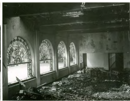
Het nieuwe pensionaat na de brand in juli 1942 (gemeentearchief Voorschoten-Wassenaar, beeldbank nrs. VS01178, VS01172, VS01159 en VS01161). De kap en eerste verdieping zijn geheel uitgebrand. De zoldervloer en kap waren van hout. Alleen de stalen 'moerbalken' bleven gespaard. De begane grond had minder schade door (gedeeltelijk) brandvrije vloeren. Ook de gevels konden grotendeels behouden worden.
