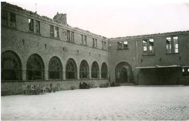
Het nieuwe pensionaat na de brand in juli 1942 (gemeentearchief Voorschoten-Wassenaar, beeldbank nrs. VS01178, VS01172, VS01159 en VS01161). De kap en eerste verdieping zijn geheel uitgebrand. De zoldervloer en kap waren van hout. Alleen de stalen 'moerbalken' bleven gespaard. De begane grond had minder schade door (gedeeltelijk) brandvrije vloeren. Ook de gevels konden grotendeels behouden worden.
