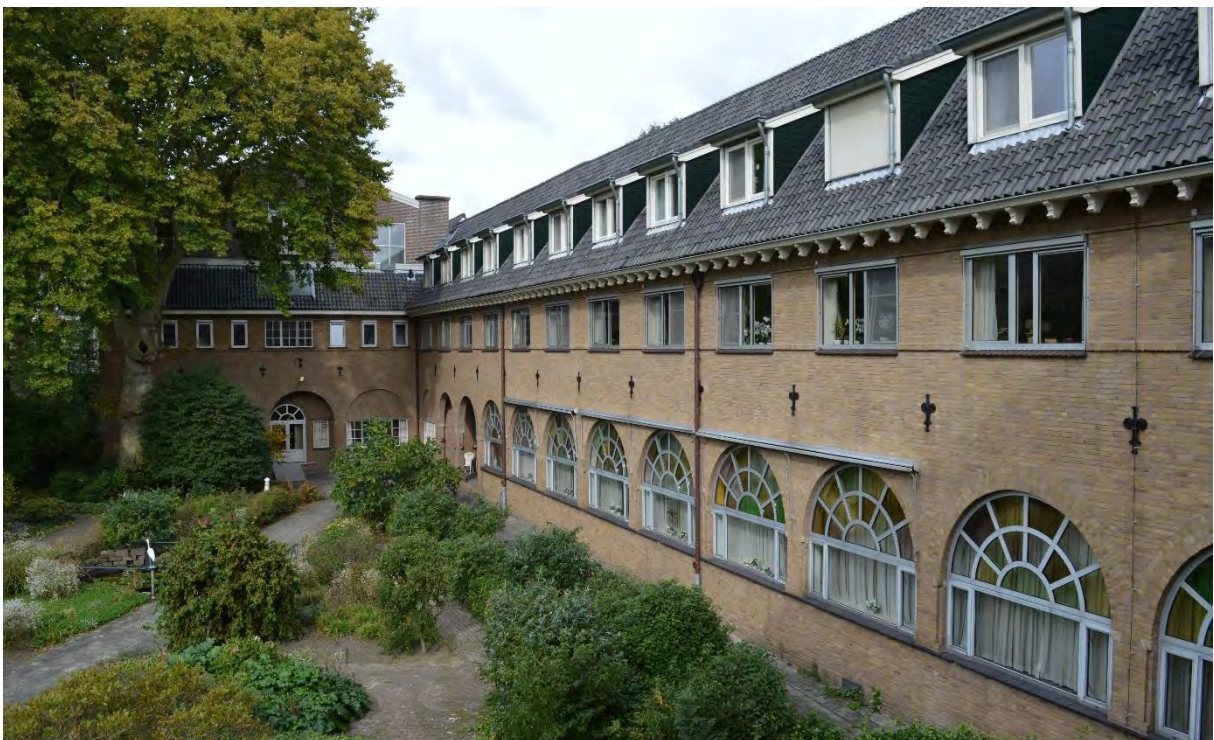
De zuidgevel van de noordvleugel van het nieuwe pensionaat, gezien vanuit de zolder van de oostvleugel. De aluminium ramen van de gymnastieksaal hebben gekleurd glas (1979). De vensters op de eerste verdieping zijn verbreed door koppeling van de oorspronkelijke vensterparen, de dakkapellen zijn vergroot.
