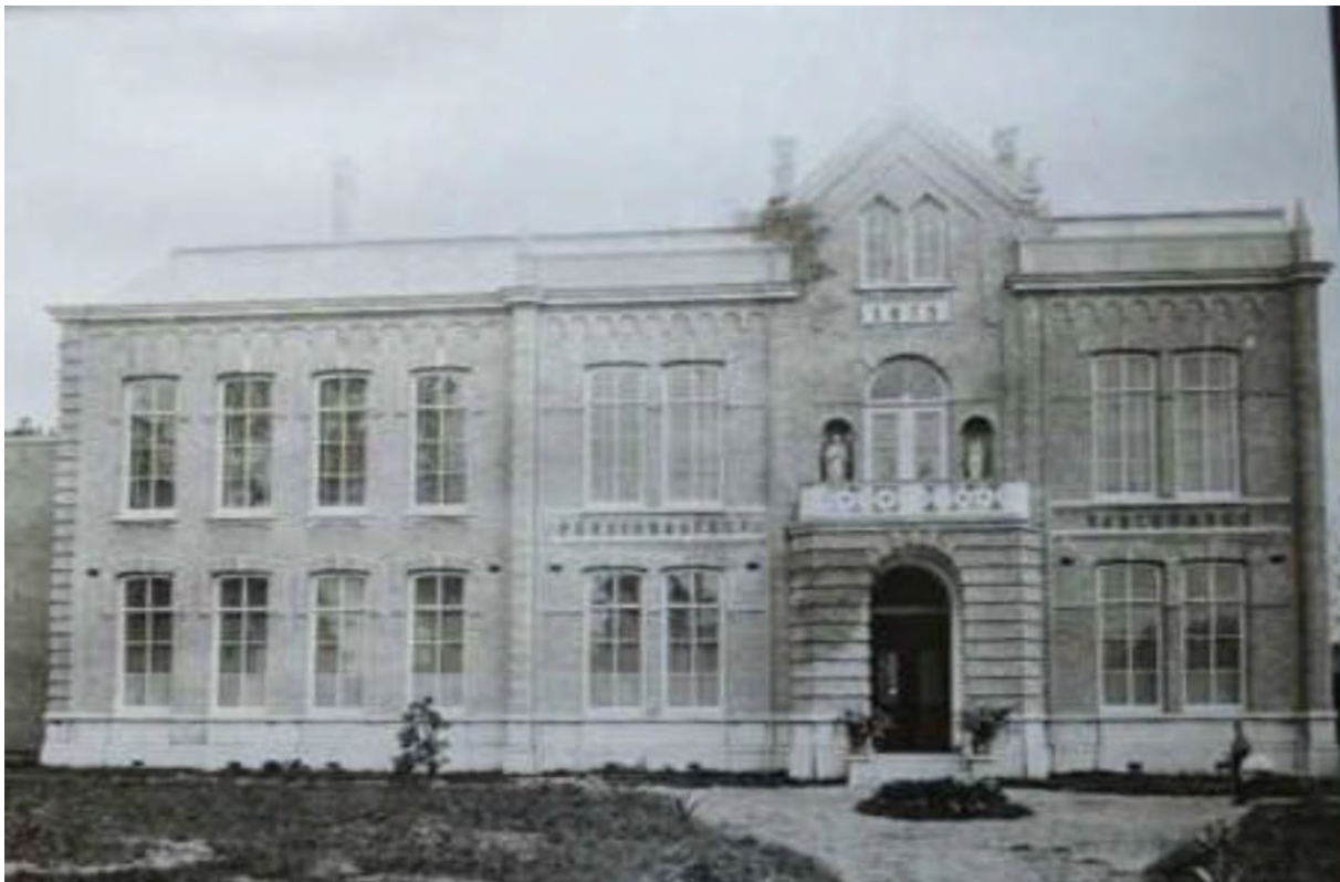
Het pensioonaat kort na voltooiing van de eerste bouwfase in 1880 (huisarchieef). De travee rechts van het trappenhuis (met aangebouwd portaal en balkon) besloeg niet de volle diepte van het gebouw. Op die wijze had men kennelijk al rekening gehouden met de uitbreiding met een soortgelijke vleugel als aan de linkerzijde.
