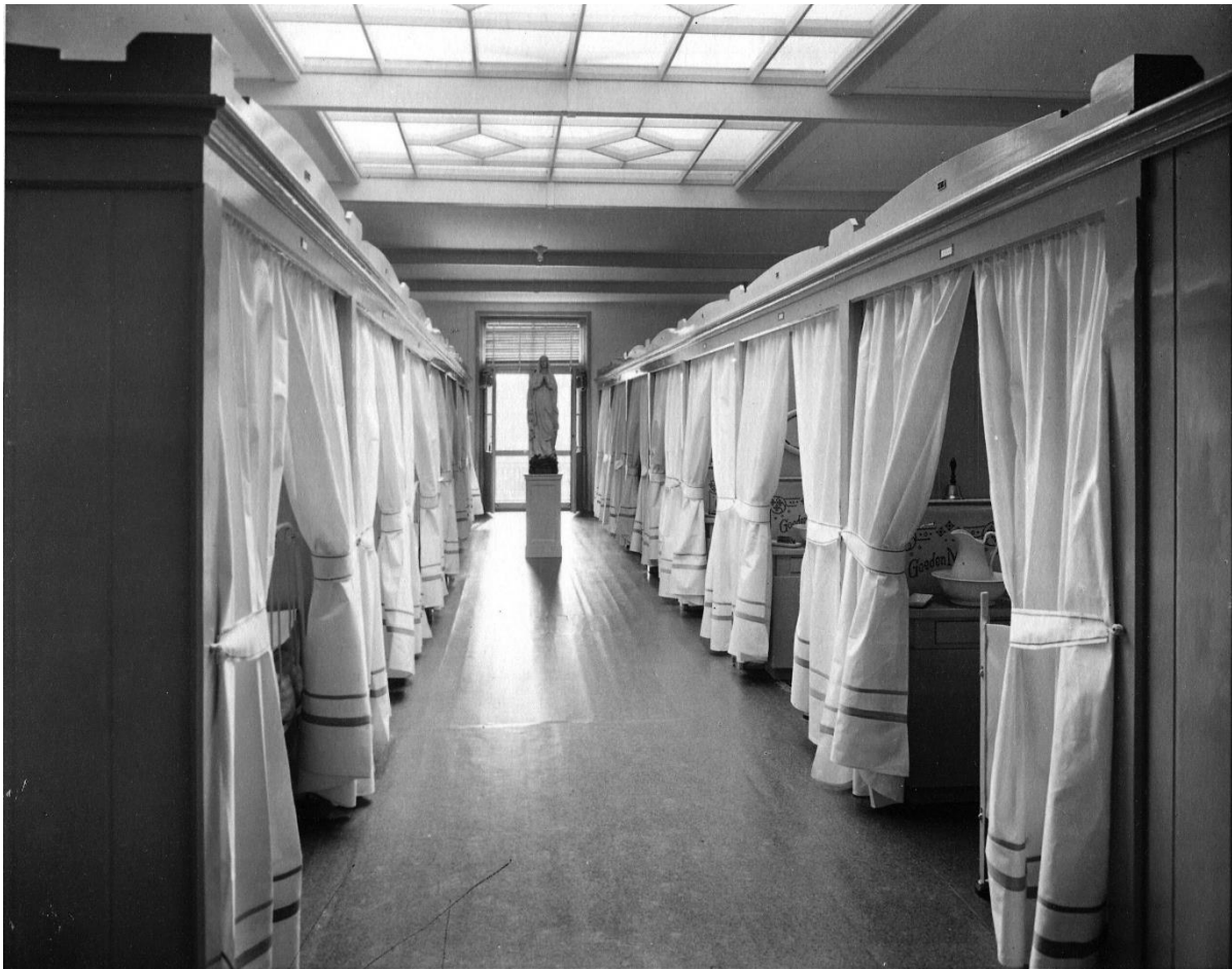
Overzicht van de nieuwe slaapzaal met chambrettes op de zolder van het pensionaat, zoals tot stand gekomen in 1922, foto 1937 (Erfgoedcentrum Nederlands Kloosterleven, ENK_AR-Z040-3011-09). Op de achtergrond is een Frans balkon herkenbaar in de oostelijke kopgevel van het pensionaat.
