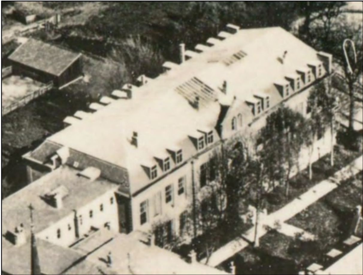
Luchtfoto van het pensionaat uit 1931, uitsnede uit een Ansichtkaart (collectie auteur). De oostelijke kopgevel is in 1922 verhoogd tot een gebroken topgevel, aansluitend op het mansardedak. In het dak zijn dakkapellen en grote daklichten aangebracht, behorend bij de nieuwe slaapzalen op de zolder.
