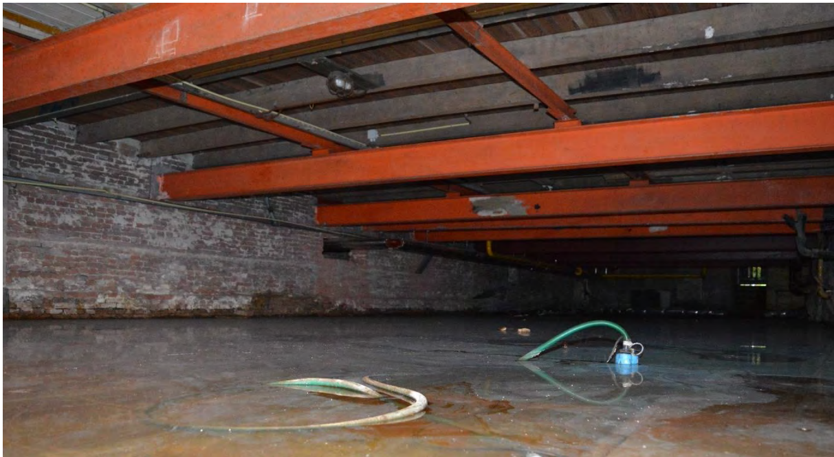
Overzicht van de lage kelderruimte in het pensionaat.
